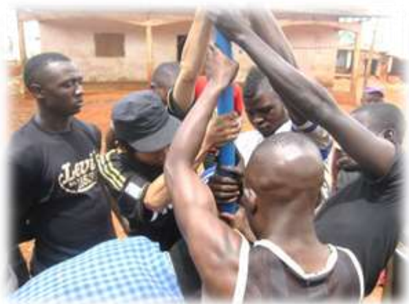
(ポンプ井戸修理時の様子)
